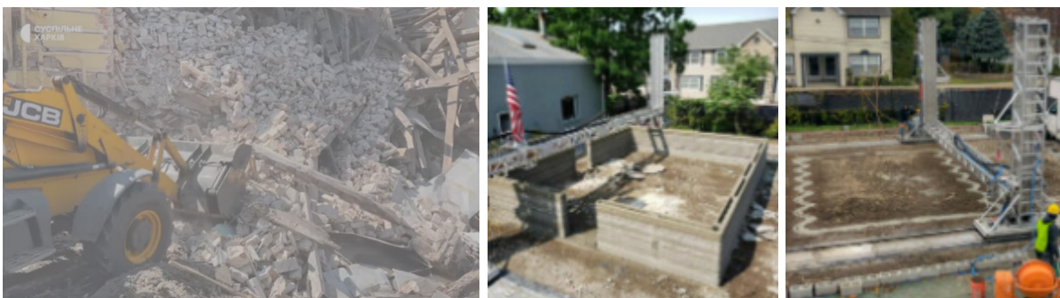
Рис. 2. Будівельні матеріали, що збираються для повторного використання у відбудові житла будівельним 3-D принтером
