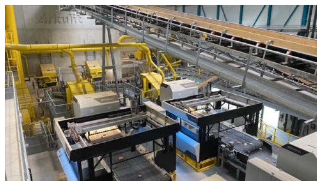
Рис. 5. Загальний вигляд ліній з роботами для сортування будівельних відходів
