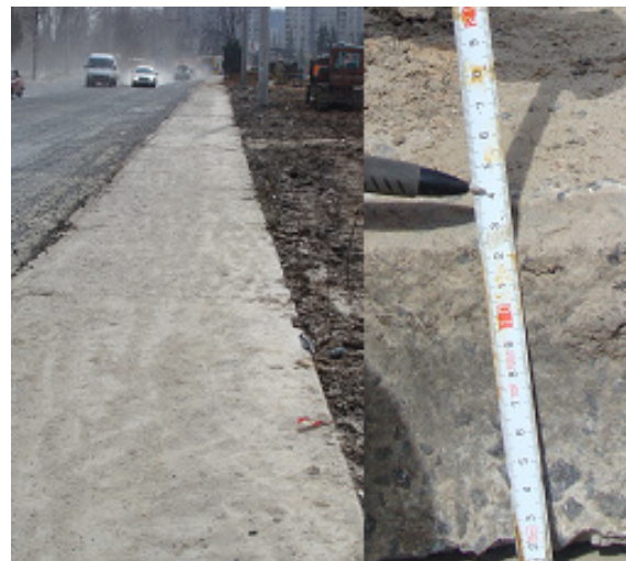
Рис. 1. Загальний вигляд досліджуваної ділянки автомобільної дороги
