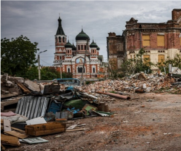
Рис. 3. Фото пошкоджених будівель м. Харкова
